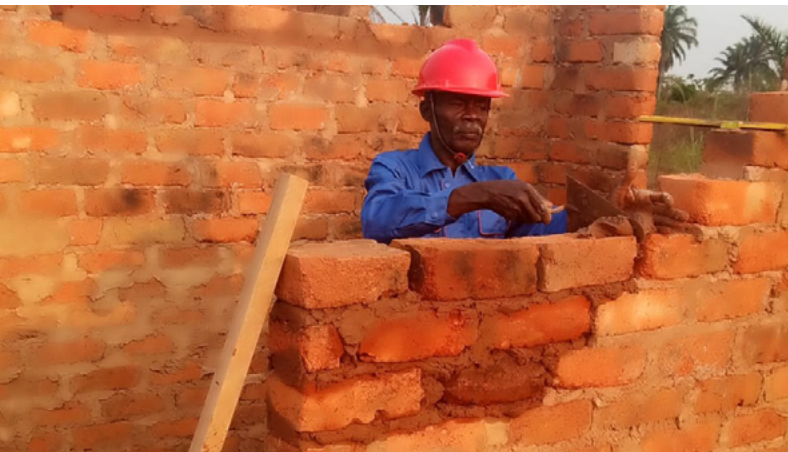
Bau der Grundschule „Mayisha“
