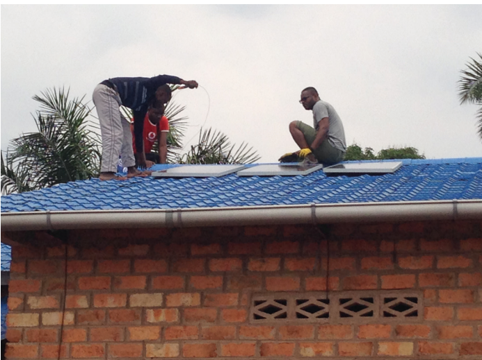
Montage der Solarpanelen auf einem Ernährungszentrum
